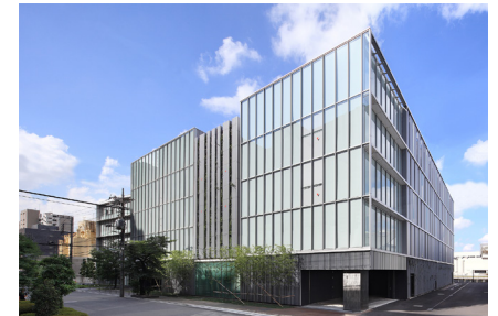
Equinix TY8 Exterior
